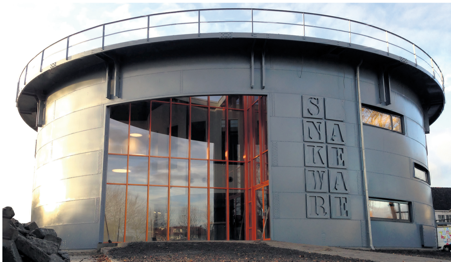
Van het ijzer dat voor de entree uit de gevel werd gezaagd, werden platen van 90 bij 90 centimeter gezaagd en daar zijn de letters van de bedrijfsnaam uit gelaserd. Die zijn, met de verweerde kant naar buiten, op de gevel bevestigd. Je moet 'slangvormig' lezen: heen en weer, van boven naar beneden - dat refereert aan de bedrijfsnaam (snake is natuurlijk ook een klankgrap die verwijst naar Sneek). Foto: Snakeware
