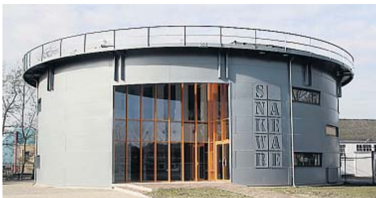
De gashouder van Sneek, wederom hergebruikt.
